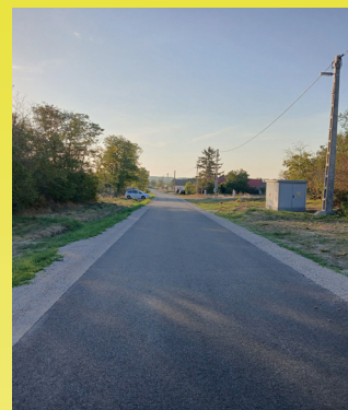
Kishegyi utca felújítás után
