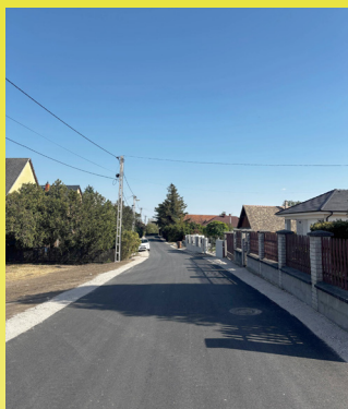
Zrínyi utca felújítás után
