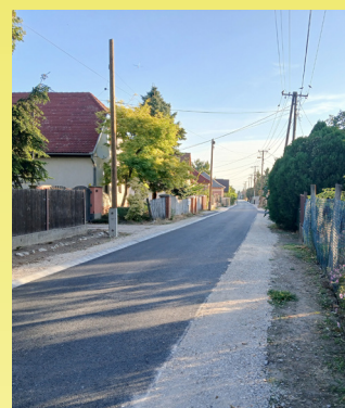
Táncsics utca felújítás után
